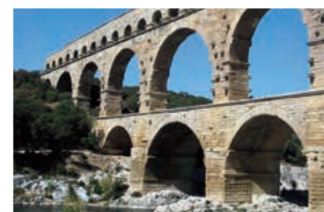
フランスの水道橋ポン・デュ・ガール
