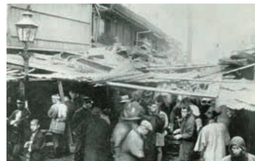
明治の日本橋魚河岸のぎわい。日本橋の周りに銀行や会社のビルなどがどんどん建てても、魚河岸は相変わらず続いていた。
