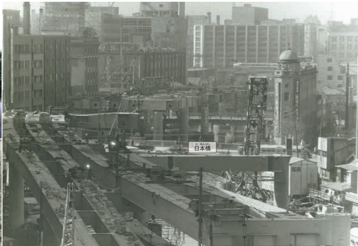
日本橋の上に首都高速道路の建設がはじまった。
