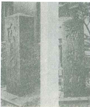
海運橋の橋柱
