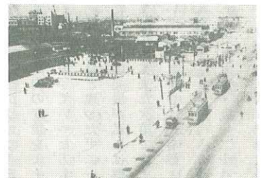
埋立後の東京駅八重洲口
